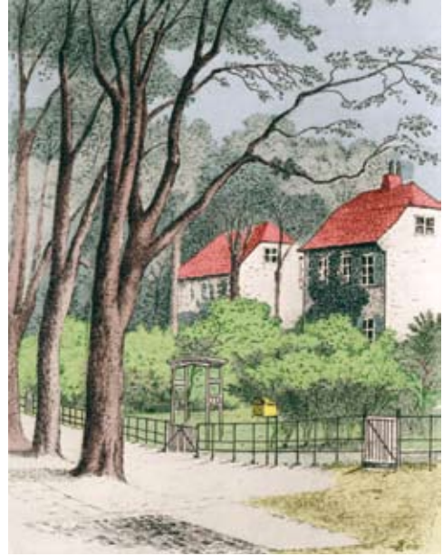
Zwei der „Teedosen“ am Mittelweg 180 und 181. Sie wurden um 1824 von John Fontenay errichtet.
