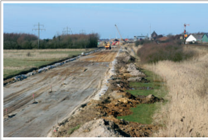
Schätze unterm Sand: Der Bau der Keitumer Umgehungsstraße förderte antike Kostbarkeiten zu Tage.
