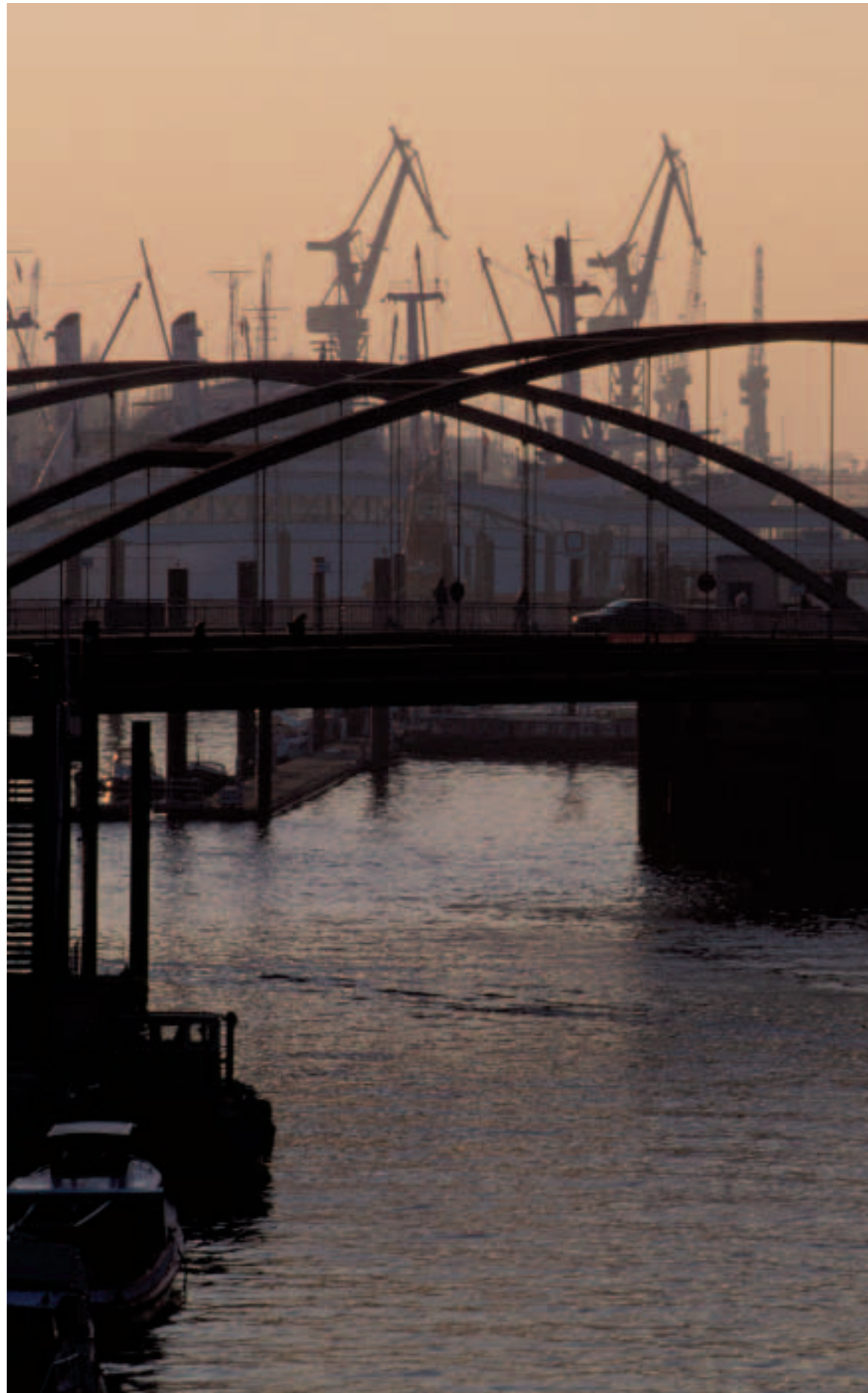
Blick vom Binnenhafen elbabwärts mit den stähler- nen Bögen der Niederbaumbrücke. Rechts die auf dem Viadukt gelegene U-Bahn-Haltestelle Baum- wall, links die Kräne der Werft von Blohm + Vöss.
