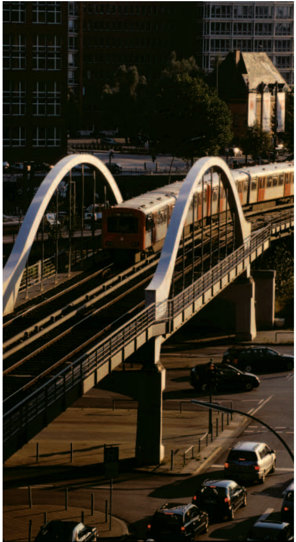
Die neue Hochbahnbrücke über die Kajen an der Einmündung in den Rödingsmarkt.
