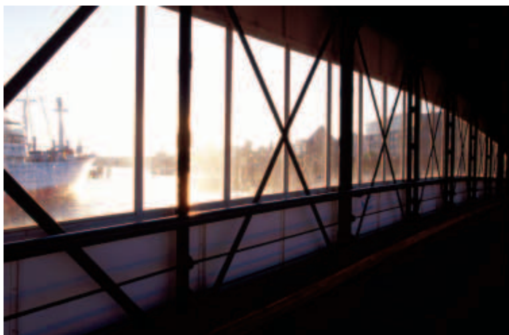
Das nüchterne Innere der Überseebrücke wird durch den Blick auf das Hafenpanorama und die „Cap San Diego“ verschönt.
