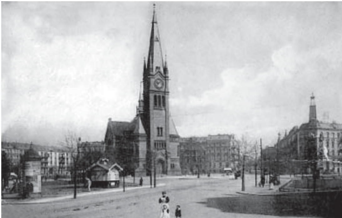
1894 wurde die Apostelkirche auf einer grünen Wiese im neugotischen Stil errichtet.
